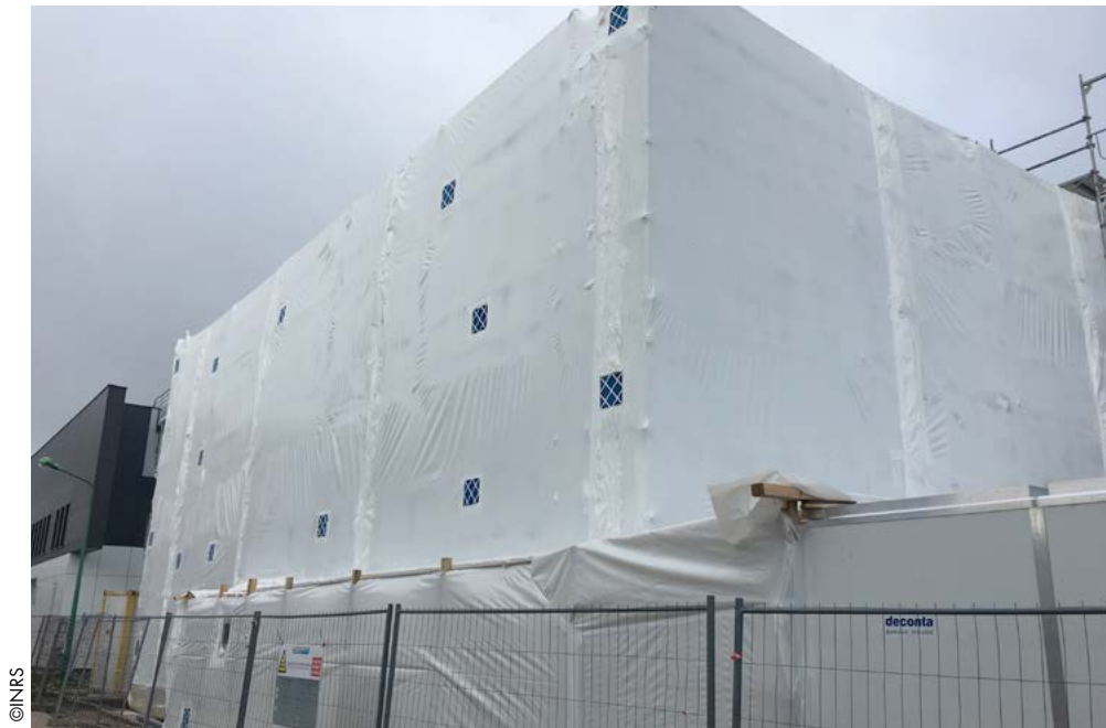
Confinement d'un bâtiment réalisé avec une bâche thermosoudée
