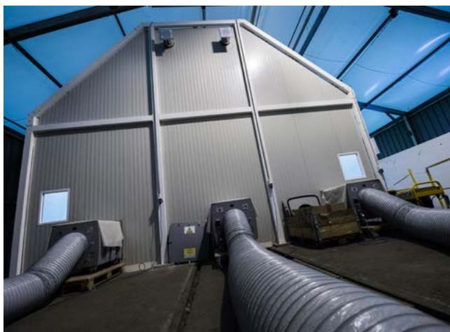
Extracteurs d'air de type H pour la filtration des fibres d'amiante dans l'air
