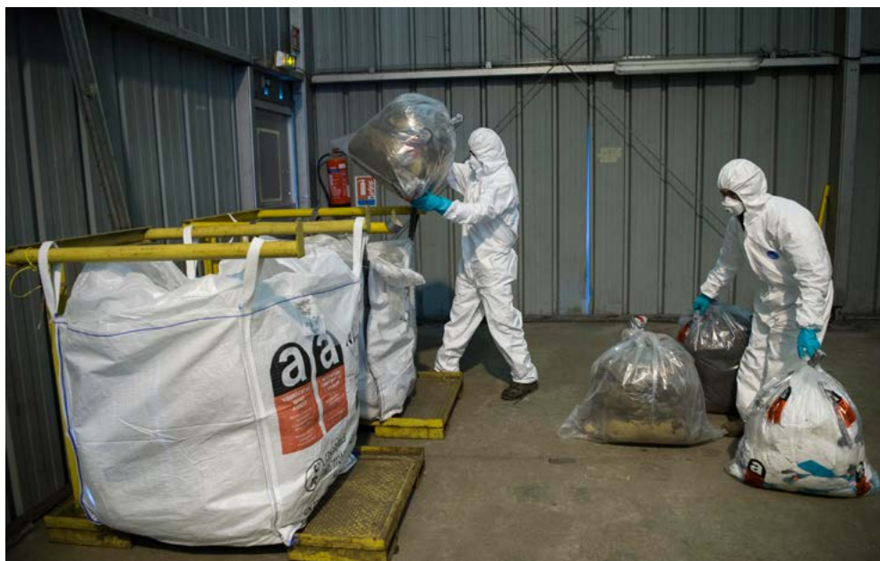
Phase opérationnelle de ramassage et conditionnement des déchets d'amiante
