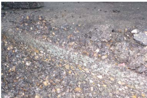
Enrobés amiantés, multicouches vues de coupe
