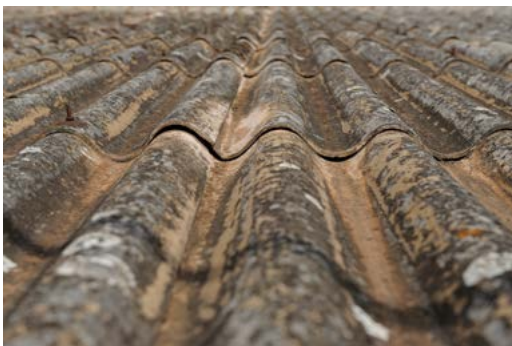
Toiture ondulée en amiante-ciment
