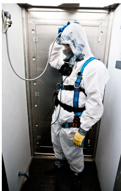
Procédure de décontamination du personnel sous la douche
