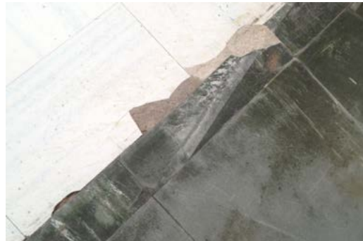
Dalles de sol en vinyle amiante
