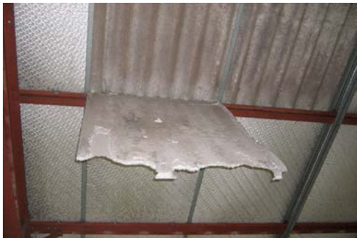
Panocell® amianté sous toiture ondulée en amiantement
