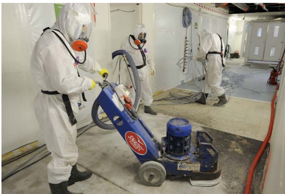
Retrait de colles amiantées avec une rectifieuse dotée d'un dispositif d'aspiration à la source
