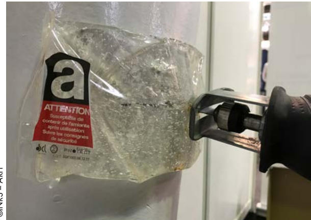
Poche de gel hydrique piégeant les fibres à la source lors de la découpe d'un conduit amiante
