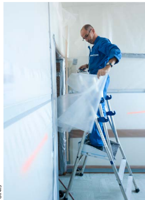
Construction d'un confinement avec des films plastique en milieu intérieur
