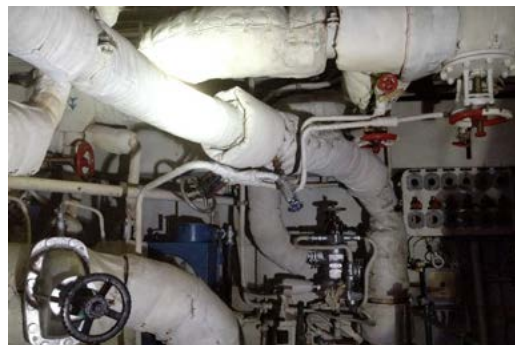
Calorifugeage amiaté
