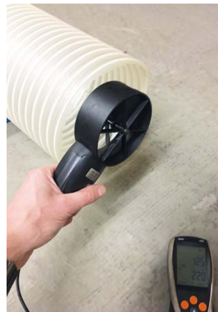
Exemple : mesure en sortie de conduit souple au refoulement d'un extracteur
